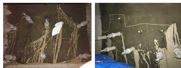
注入材 A-1 注入完了
