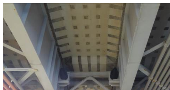
写-1 対象橋梁床版下面補強状況(格子貼り)
