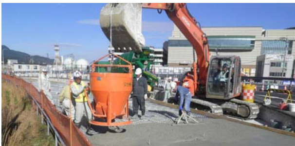
写真-2 実施工時の打設状況
