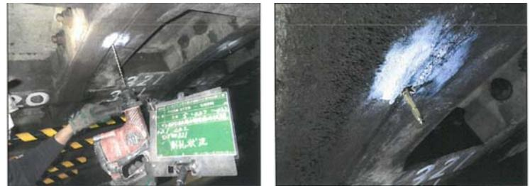
写真 1 現地試験止水工
