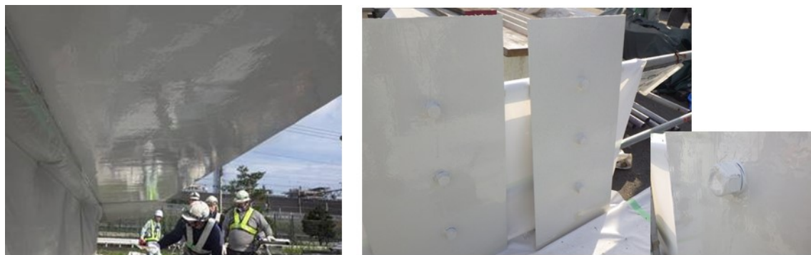
図-3 試験施工後の外観状況（コンクリート面及び鋼板及びボルト部）
