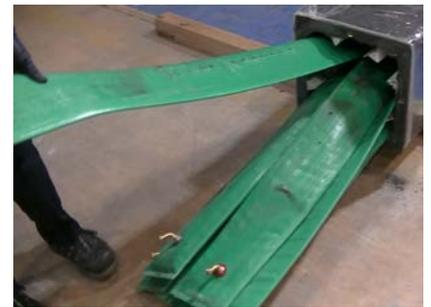
写真-3 エアチューブの撤去状況
