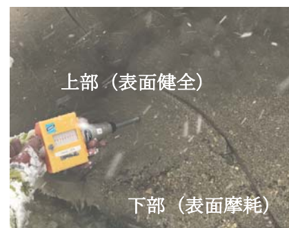
写真-4 測定状況
