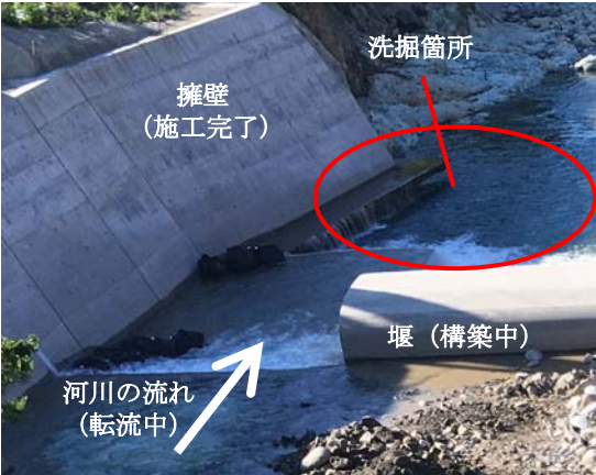
写真-1 河川状況
