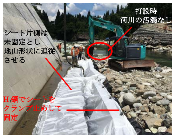
写真-2 布製型枠設置・打設状況
