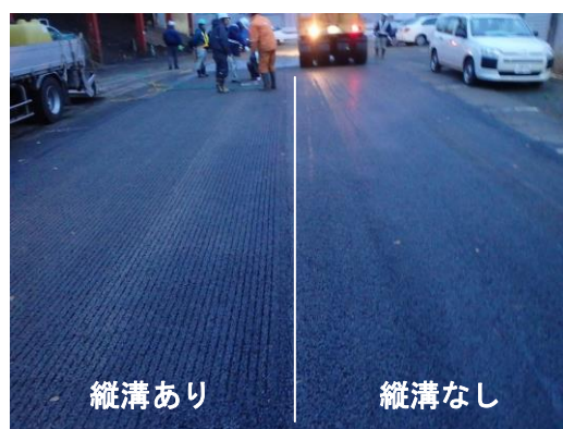
写真-1 試験施工ヤード
