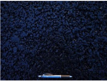
写真-2 縦溝なし路面の例
