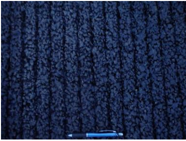
写真-3 縦溝あり路面の例
