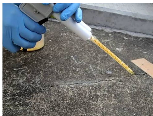
写真 1 ひび割れ注入例
