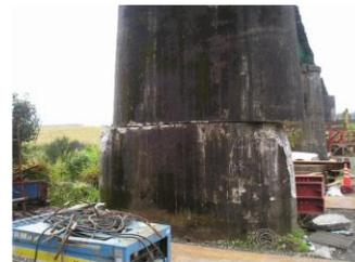
図-2 無筋橋脚の被災例<sup>1)</sup>
