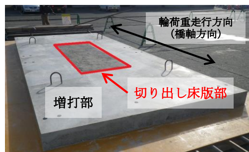
写真-1 切り出し供試体
