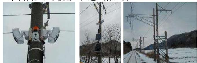
写真2~4 動物侵入検知通報装置
