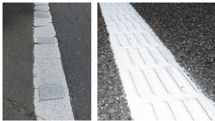
図-3 リブ付き外側線（左）、外側線の突起施工（右）
