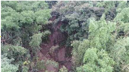
（UAVによる災害部近接撮影）
