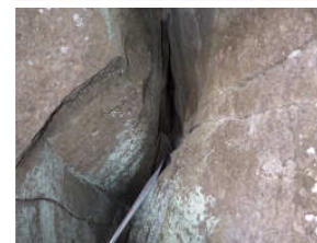
写真-3. 開口亀裂
