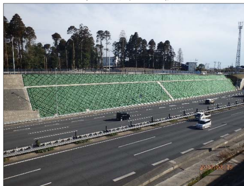
写真-3 恒久対策工 施工完了
