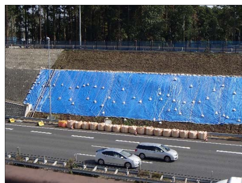
写真-2 応急対策状況
