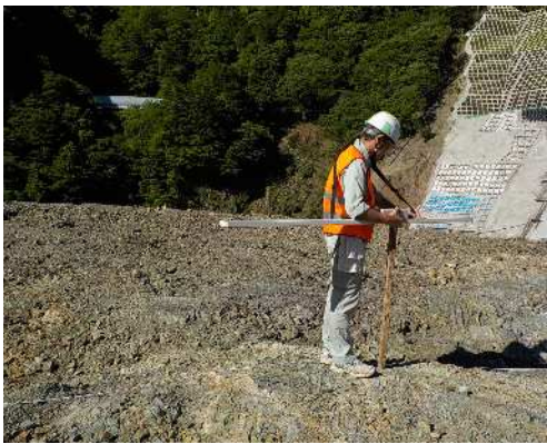
写真-2 EM 探査測定状況
