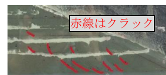
写真2 法尻の拡大図
