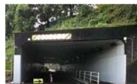
(a) 坑口（終点側）
