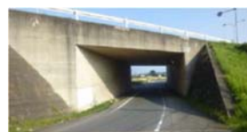
(a) 坑口（起点側）
