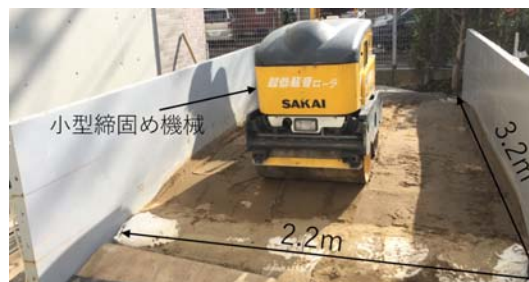
写真 1 試験盛土作製状況
