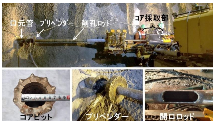
写真-1 PS-SR 工法の主要ツール設置状況
