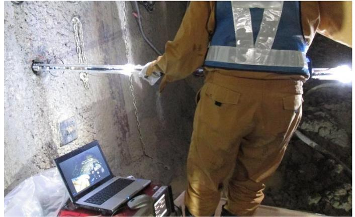
図-3 ボーリング孔内変位計の挿入状況
