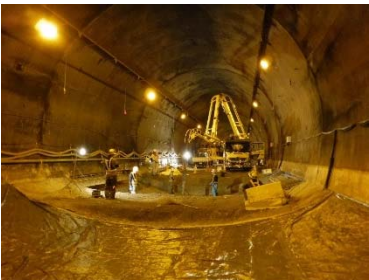
写真-2 インバート施工状況
