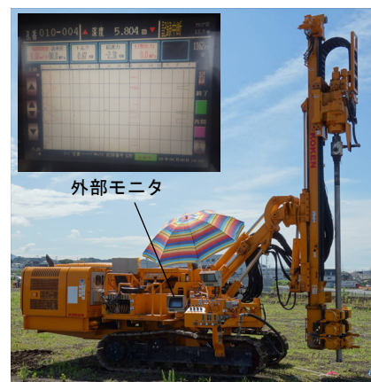
写真-2 削孔検層の使用マシン （鉤研工業製 RPD160、削孔径 90mm）
