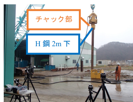
写真-1 計測マーカ取付け状況 （試験 A）
