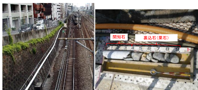
写真1 耐震補強箇所
