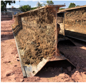
写真－2 土砂付着状況
