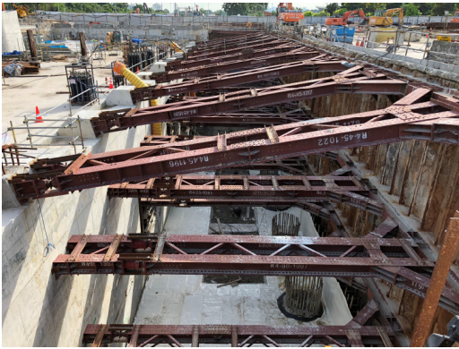
写真－1 エントランス部土留め支保工
