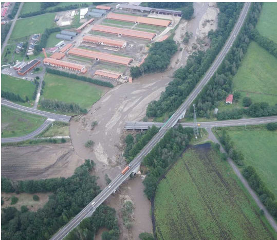
図-1 平成 28 年 8 月北海道豪雨による十勝川水系小林川に架かる橋梁被災状況
