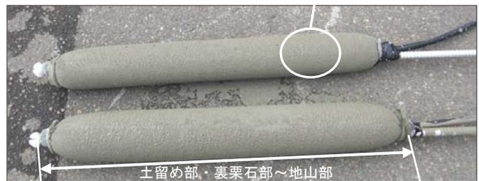
写真-2 定着材 充填後
