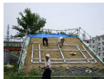
写真-2 鋼製格子枠組立
