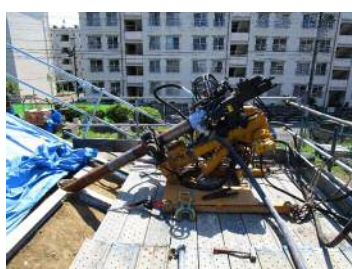
写真-3 地山補強材設置
