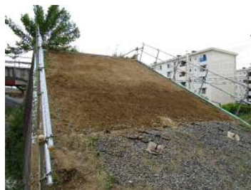
写真-1 のり面整形
