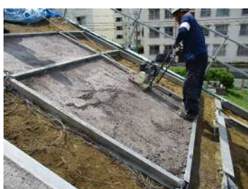
写真-7 締固め
