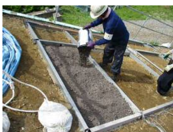
写真-5 遮水材撤出し
