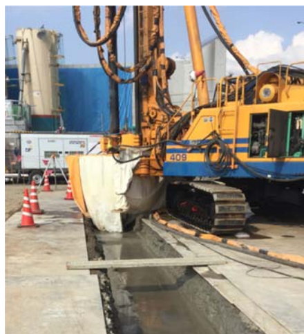
写真1 施工状況写真
