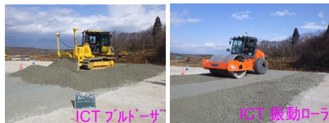
写真-1 ICT 重機による試験盛土の状況
