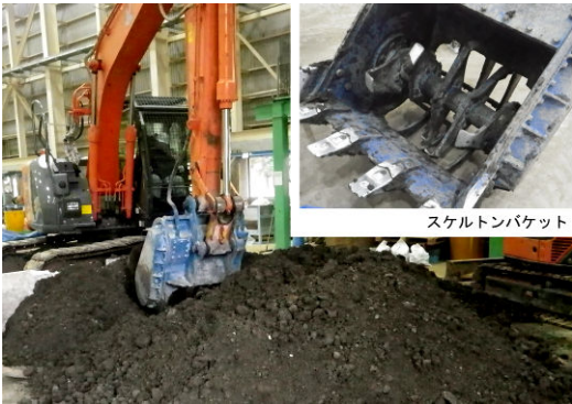
写真1 機械攪拌による混合状況
