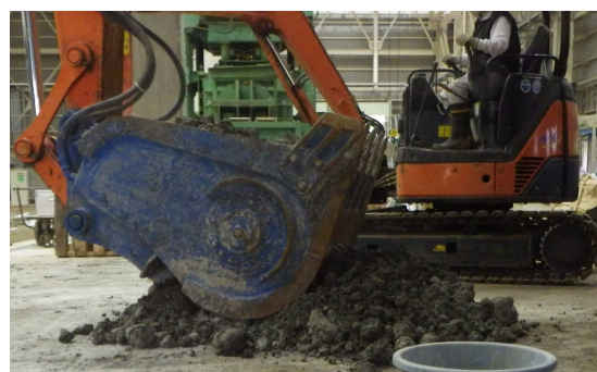
写真1 機械攪拌の様子
