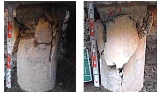
写真 1 既存杭の損傷状況<sup>1)</sup>
