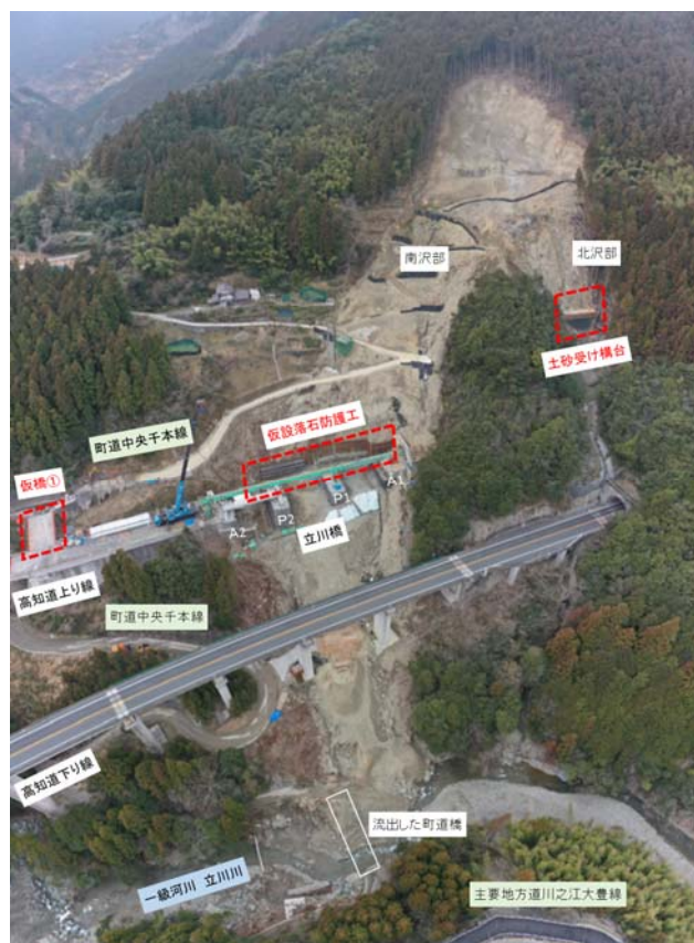
写真-1 工事現場全景（H31.3.2 時点）
