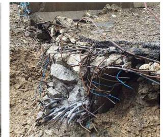
写真4. G3桁破壊断面
