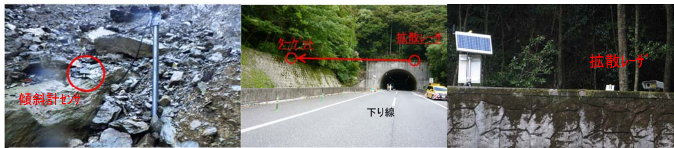
図-3 変位計設置状況
