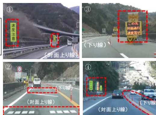
写真-2 安全対策の実施状況
