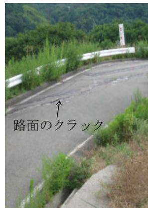
図-2 路面のクラック (写真撮影①)
