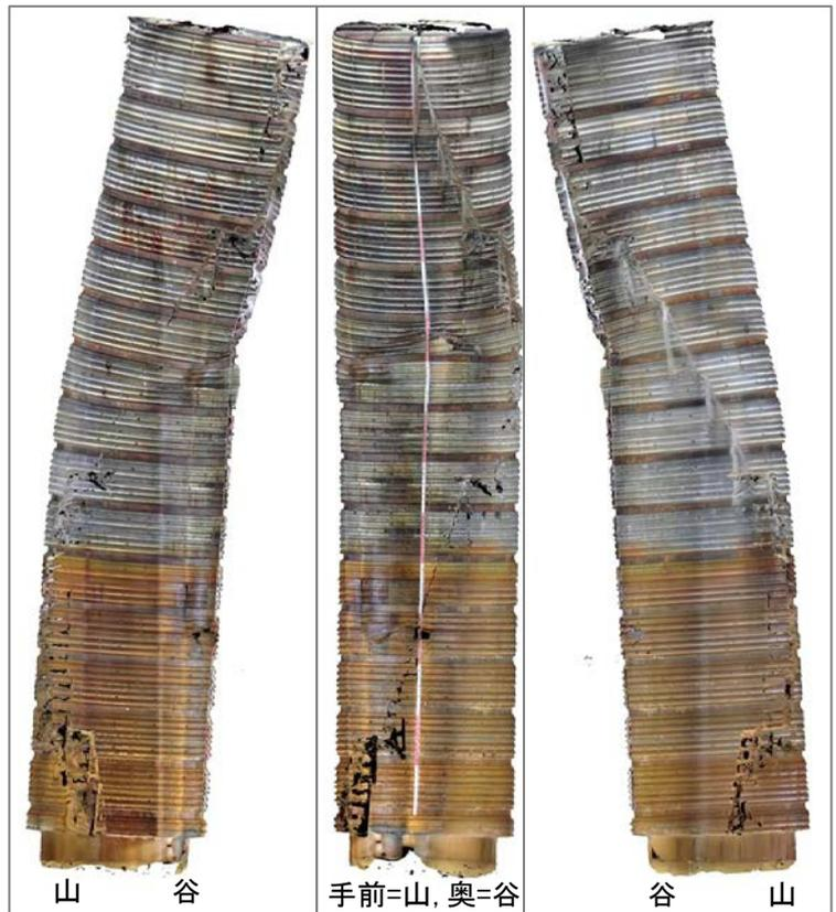
図2 集水井工の3Dモデル例（東北森林管理局管内）
