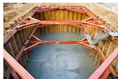
写真-1 実物大試験土槽
