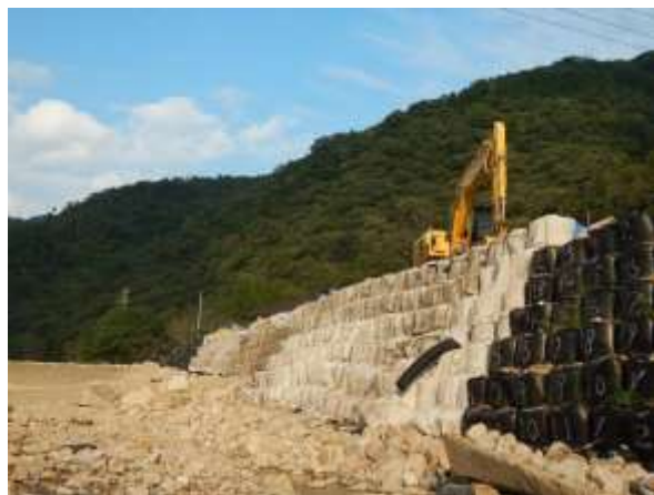
写真-2 損傷を受けた仮復旧箇所での GCCM による被覆補強
