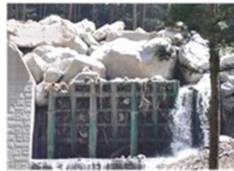
写真-1 透過型砂防堰堤
