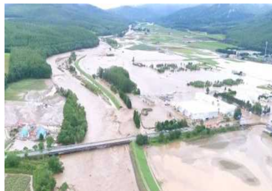
写真-1 堤防決壊（南富良野町：北海道開発局提供）
