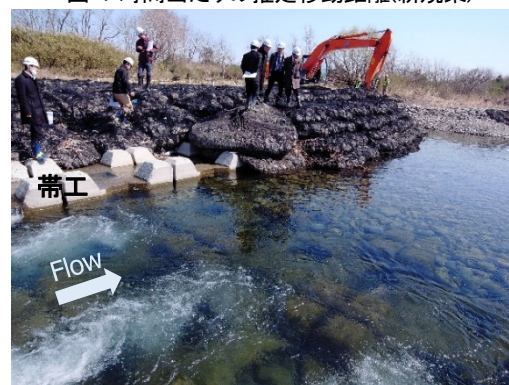
図-8 新たに設置した帯工袖部の袋詰玉石工の全景と近景
