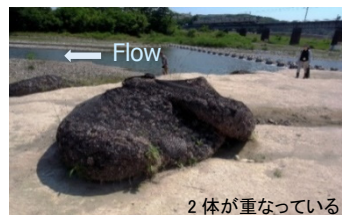
図-2 移動した袋詰玉石工の近景
