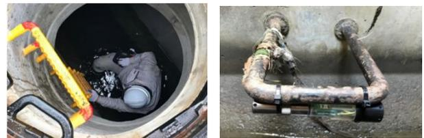
図-1 水位計設置の様子
