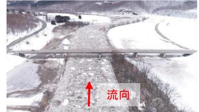
写真-1 常呂川でのアイスジャム (2018年3月10日忠志橋付近: 国土交通省北海道開発局網走開発建設部提供)
