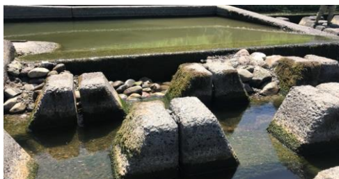
写真1 久慈川に施工された石組み魚道
