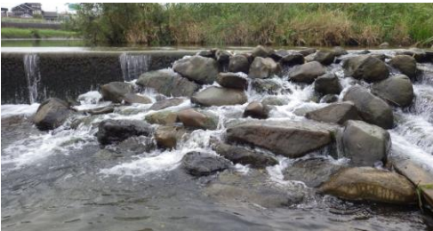
写真2 紫川葛葉井堰に設置された石組み魚道
