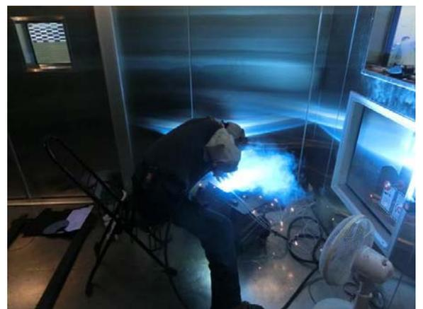
図-2 環境試験槽内における溶接施工状況
